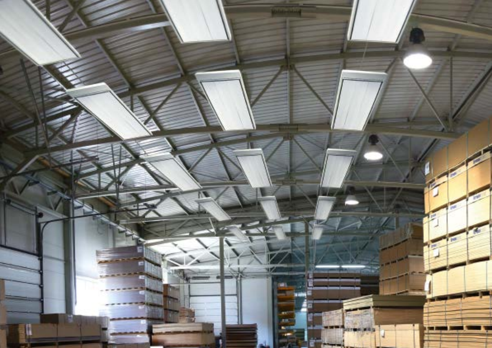
Infrarot-Hochtemperatur-Strahler - Deckenmontage in Lagerhalle
