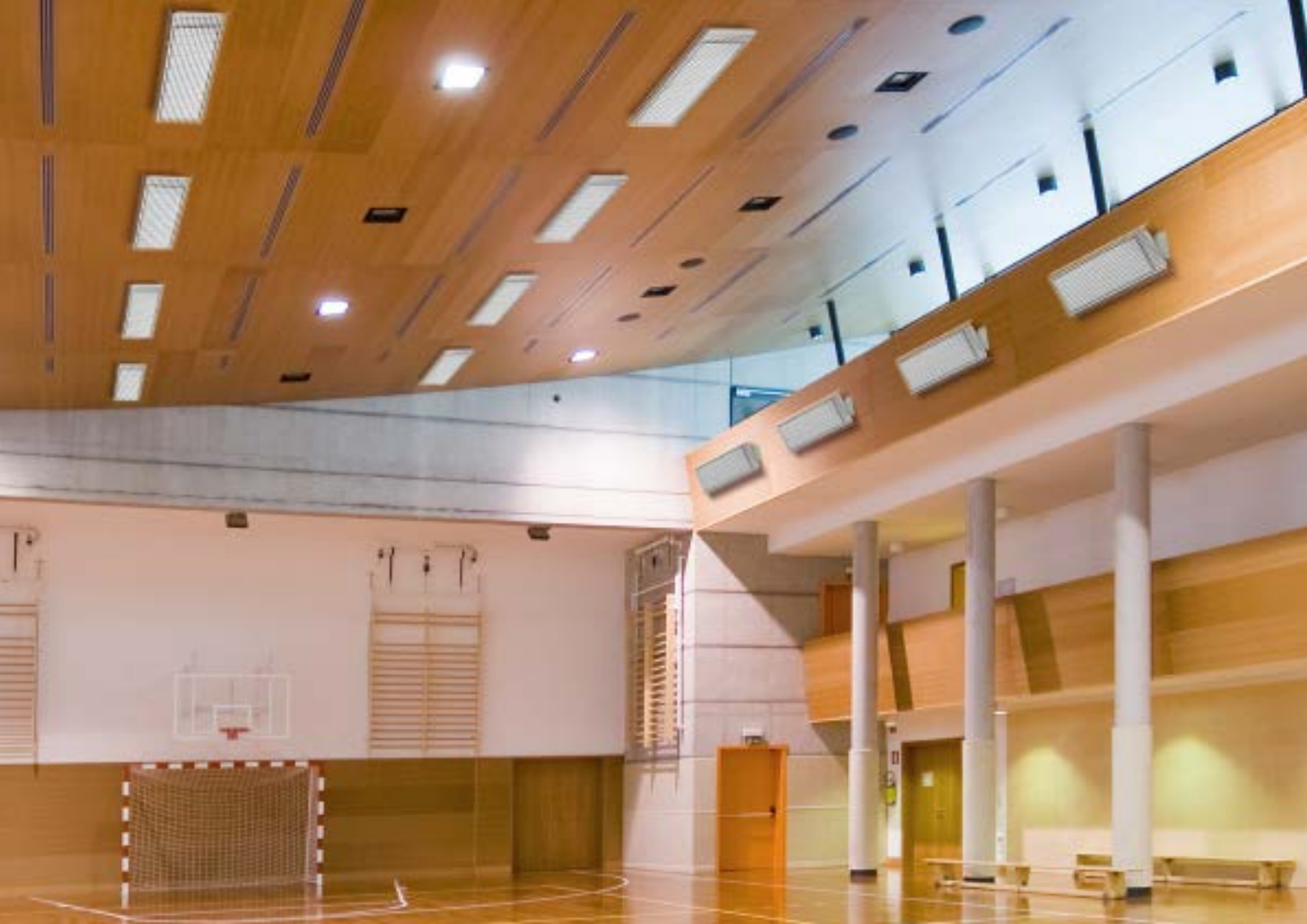
Infrarot-Hochtemperatur-Strahler mit Schutzgitter - Decken- und Wandmontage
